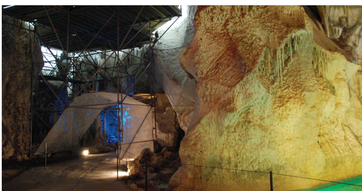
Arbeitsgerüst des Restaurators mit Schutzkonstruktion über der Führungslinie der Besucher
