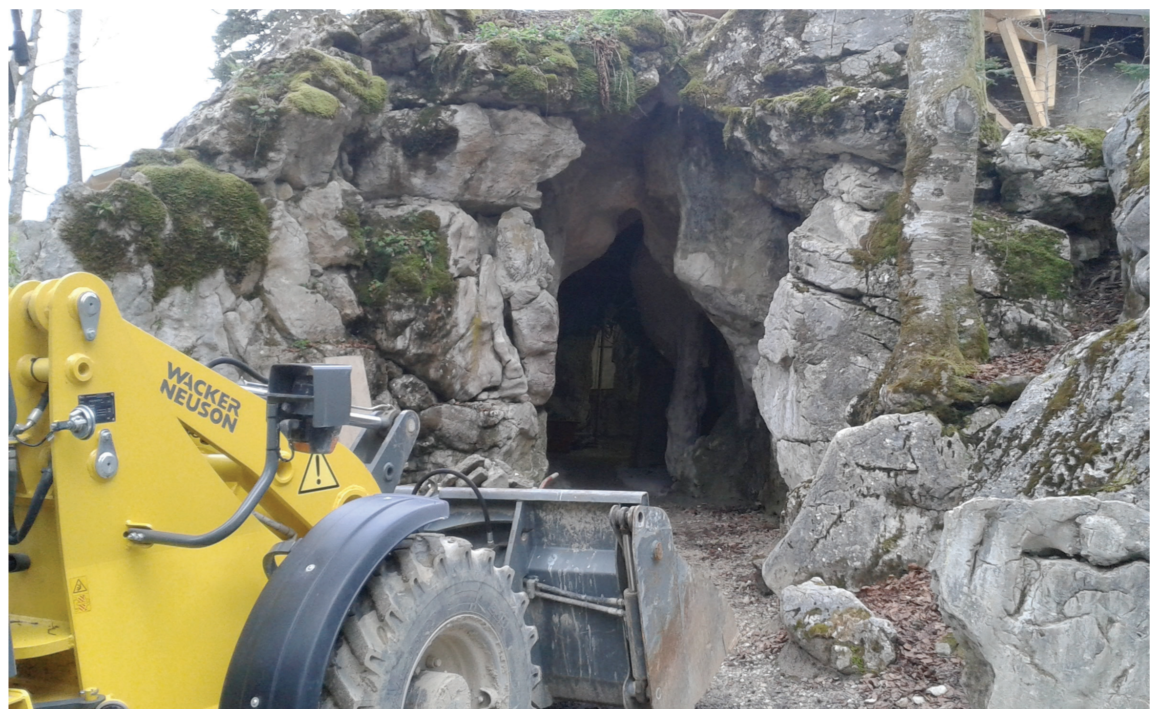
Bauarbeiten im Außenbereich der Venusgrotte
