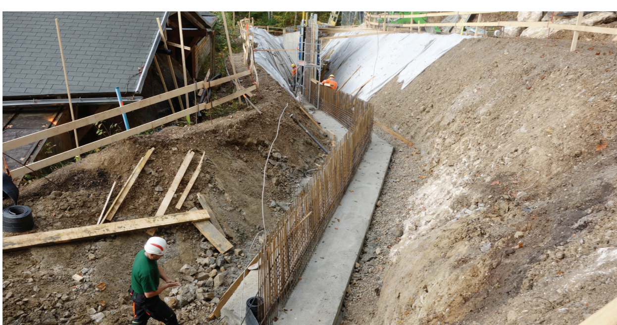
Bau der unterirdischen Sperrmauer im Herbst 2015
